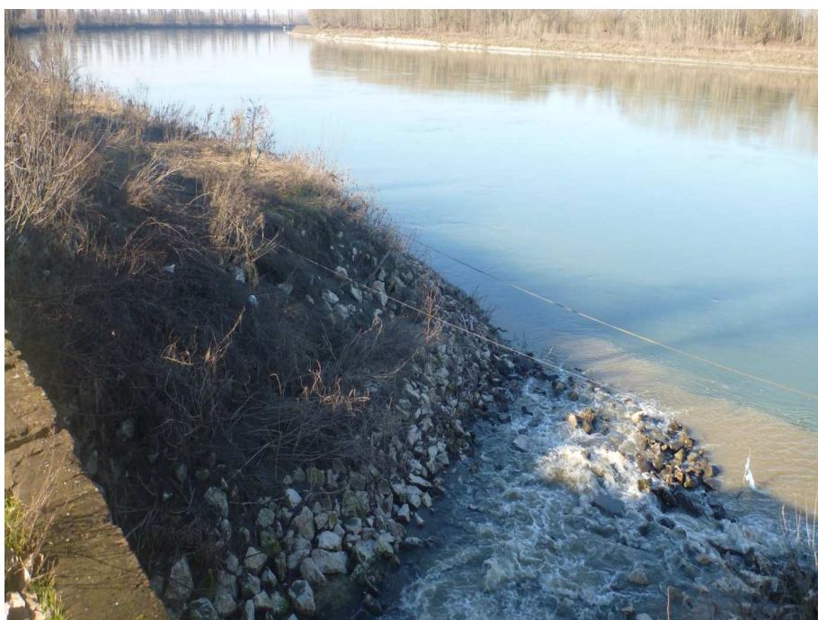
Figura 12: Vista delle porzioni di difesa a ridosso del ponte da ripristinare (lato sinistro)
