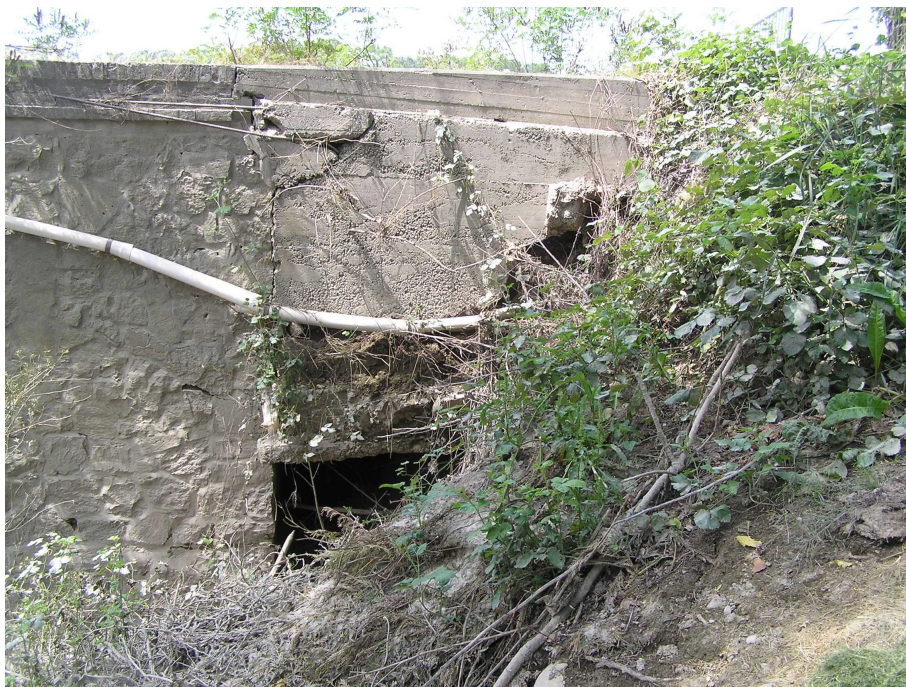
Figura 7: Vista del cedimento che ha interessato la spalla destra del ponte
