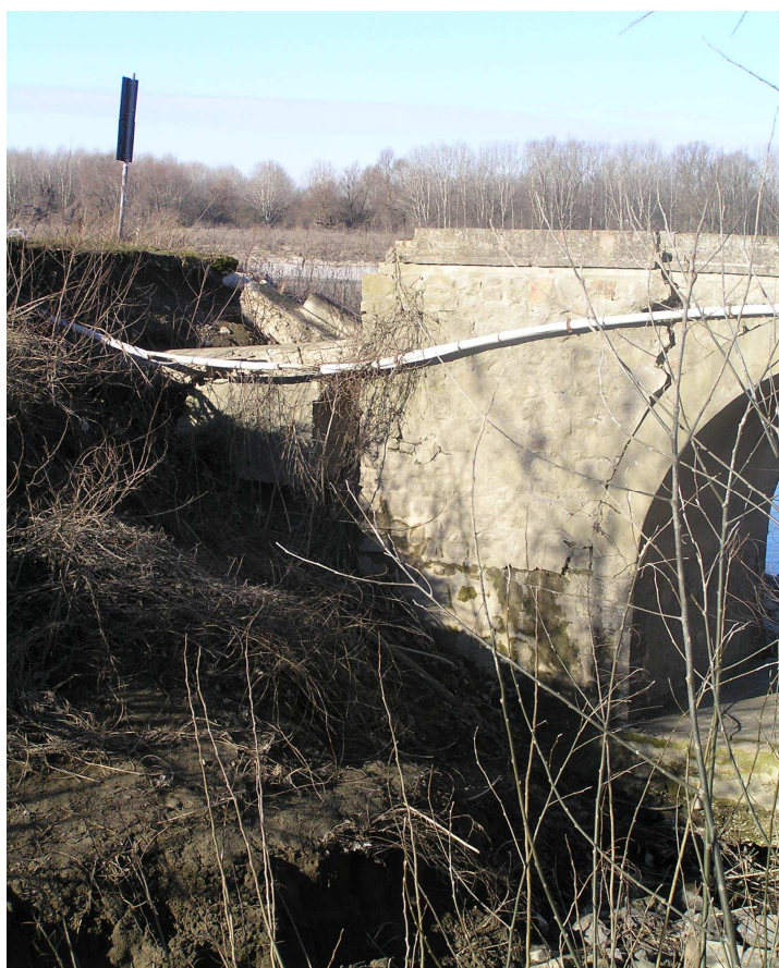
Figura 6: Vista del cedimento che ha interessato la spalla sinistra del ponte
