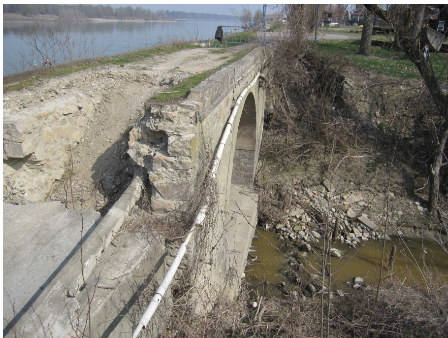
Figura 5: Vista del cedimento che ha interessato la spalla sinistra del ponte
