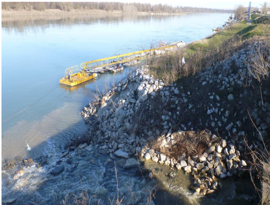
Figura 11: Vista delle porzioni di difesa poste a ridosso del ponte da ripristinare (lato destro)
