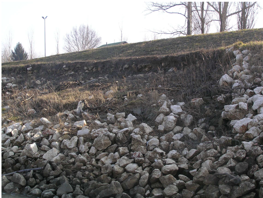
Figura 2: Particolare della difesa spondale da ripristinare
